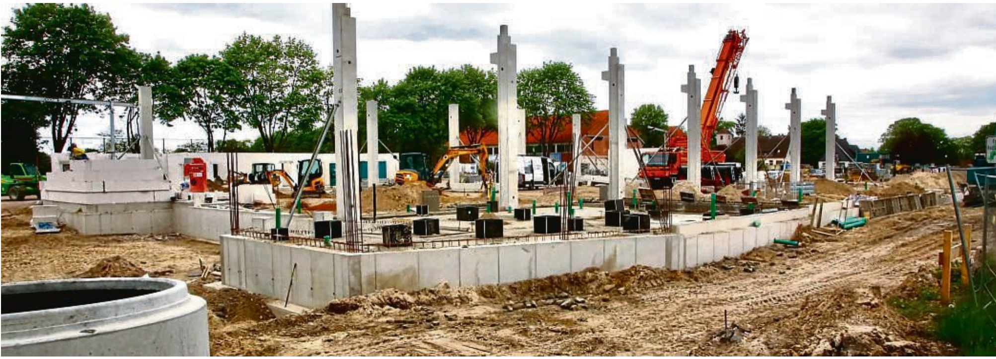
Die ersten Stahlbeton-Stützen sind errichtet: Weitere werden folgen.
